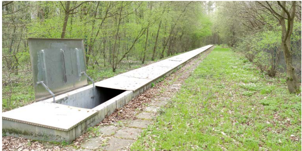
Infiltrationsgraben im Gernsheimer Wald
