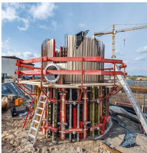
Das wird einmal der sogenannte Tiefsandfang
