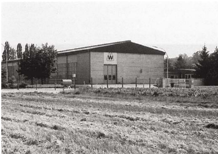
So sieht das Wasserwerk (noch) heute aus
