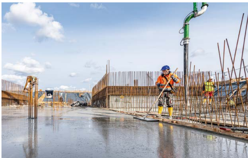
Glättarbeiten am frisch eingebauten Beton
