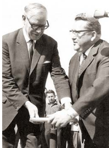
Ministerpräsident Georg-August Zinn öffnet gemeinsam mit dem Frankfurter Bürgermeister Rudolf Menzer den Schieber für die erste Wasserlieferung nach Frankfurt
