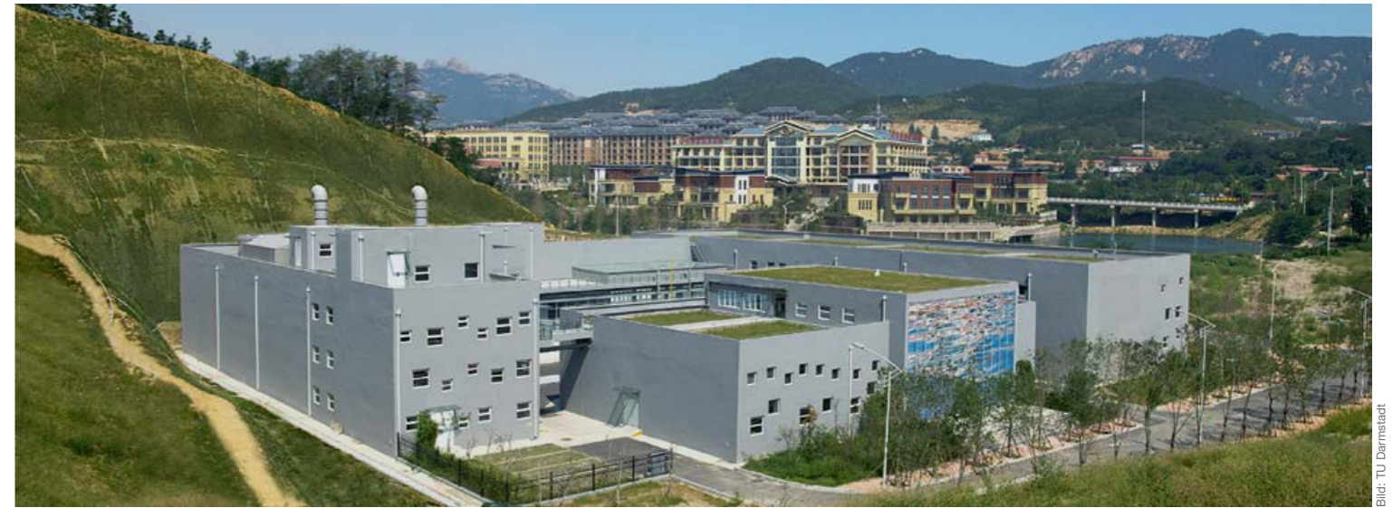
Das Resource Recovery Center im neuen Stadtteil Qingdao, in dem die Abwasseraufbereitung für die Wiederverwendung erfolgt
