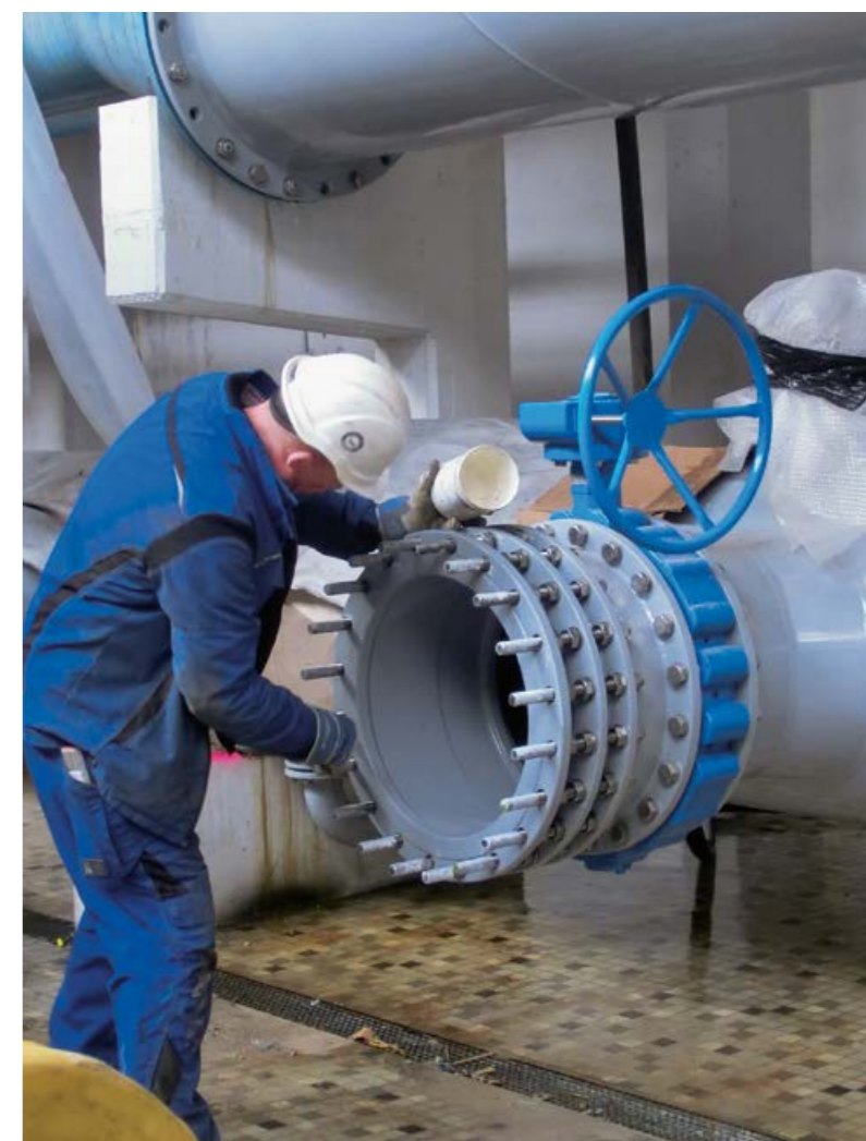
Große Rohrquerschnitte und Armaturen minimieren die Druckverluste im Wasserwerk.
