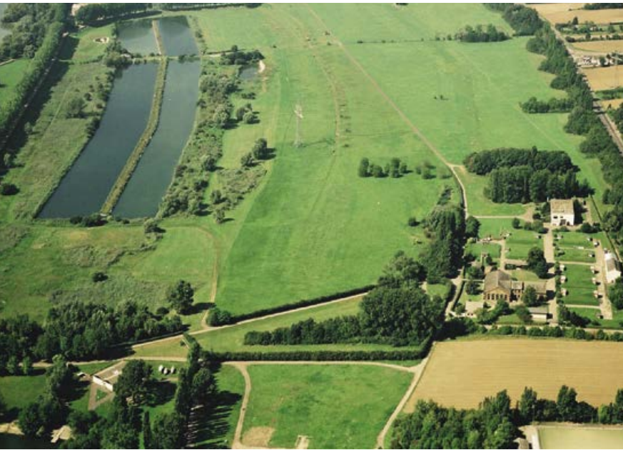
Das Wasserwerk Schierstein der Hessenwasser am Rhein
