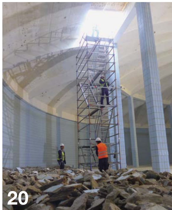
Ein Projekt für viele Jahre: die Instandsetzung der gesamten Behälteranlage in Rüsselsheim-Haßloch
