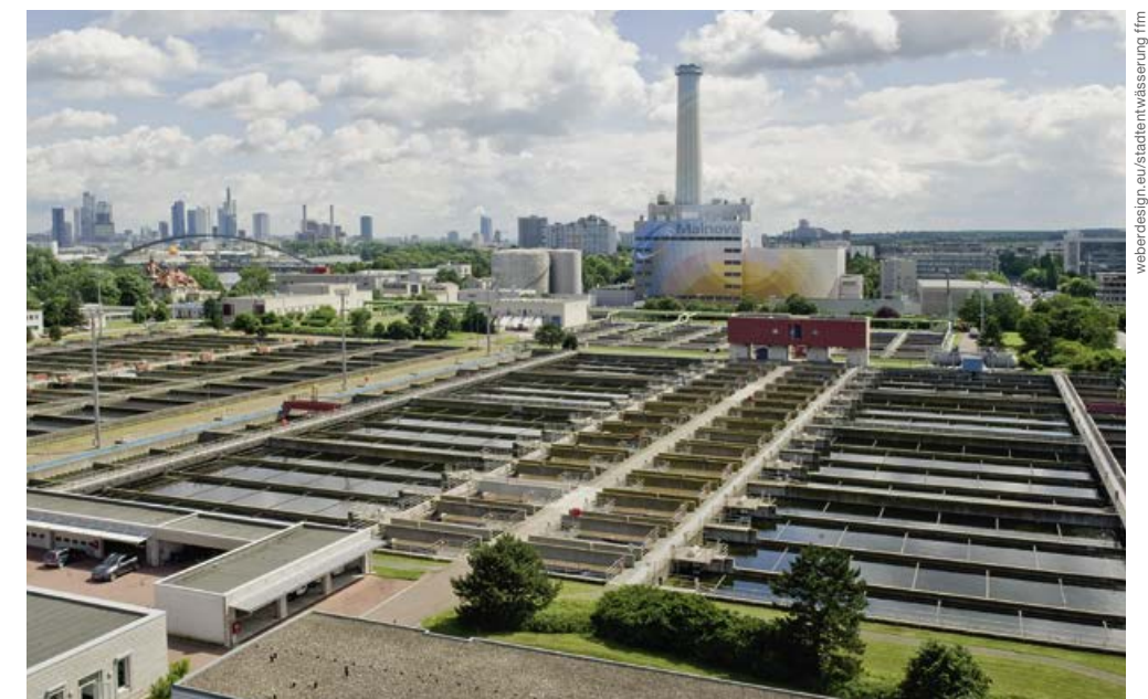
Luftbild der ARA Niederrad und der MWA
