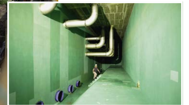
Unten: Reinwasserkammer für aufbereitetes Trinkwasser
