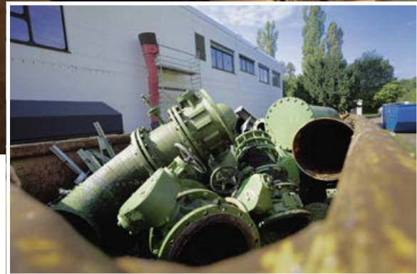
Für die Umrüstung werden die alten Leitungen zersägt und entsorgt.
