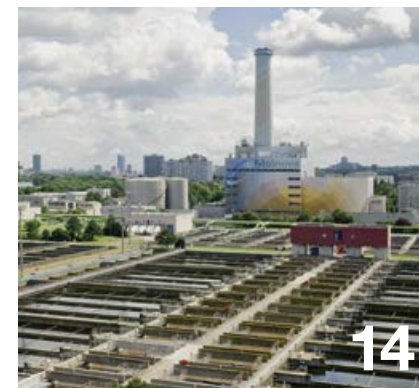
Brauchwasser aus der Mainwasseraufbereitungsanlage wird als Betriebswasser für die Abwasserreinigung in Frankfurt-Niederad eingesetzt.
