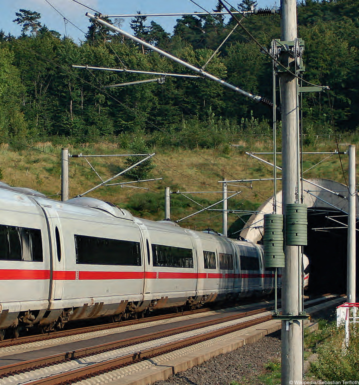
Beim Bau neuer ICE-Trassen, die durch Trinkwasserschutzgebiete führen, achtet Hessenwasser auf den Schutz des Grundwassers.
