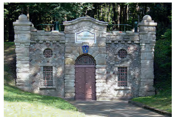
Eingangsbauwerk der Wassergewinnung „Schlääferskopfstollen“ in Wiesbaden
