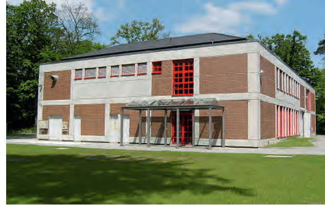
Die Filterhalle des neuen Wasserwerks Goldstein im Frankfurter Stadtwald
