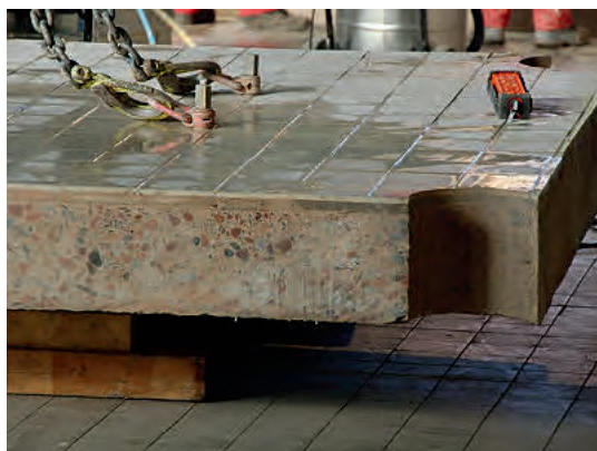
Im Zuge der Umbauten waren im Werk Haßloch unter anderem Hunderte von Tonnen Beton herauszutrennen, um Platz für die neuen Anlagen zu schaffen.
