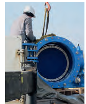
Neue Absperrklappen vor dem Einbau.
