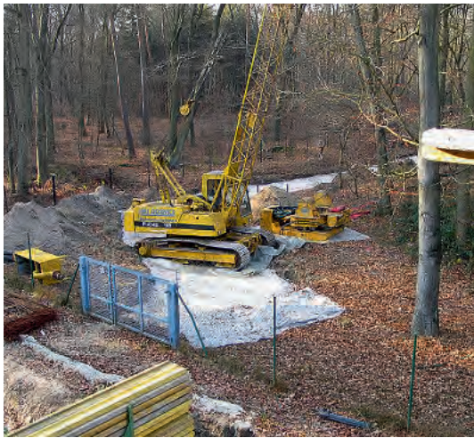
Einbau der neuen, unterirdischen Abscheideanlage für das The-Squire-Sickerbecken.
