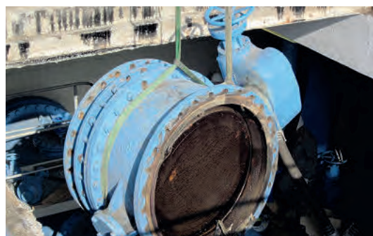
Demontage einer alten Absperrklappe (DN 1000).
