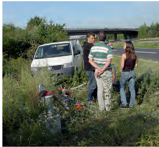
Pumpversuch zur Bewertung der Wasserhaltungsmaßnahmen für den S-Bahn-Bau.
