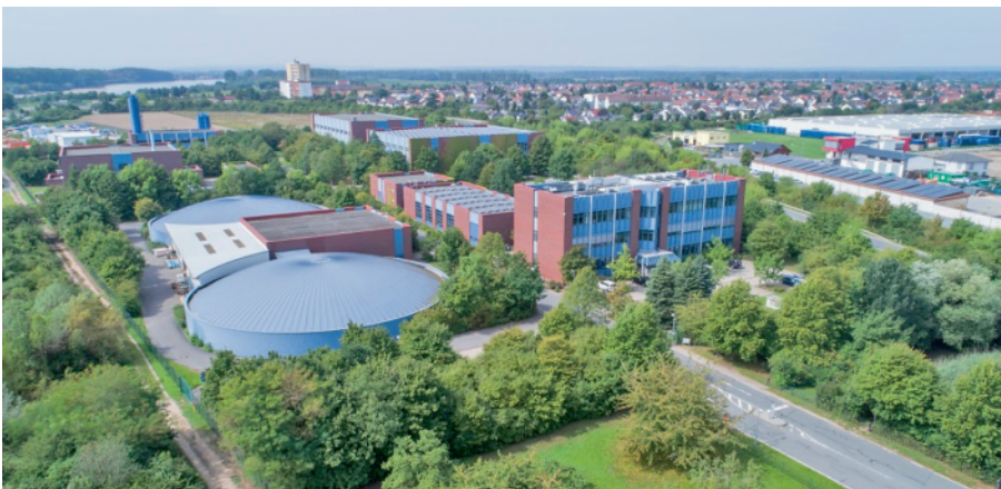
Bild 4: Rheinwasseraufbereitung im Brauchwasserwerk in Biebesheim
