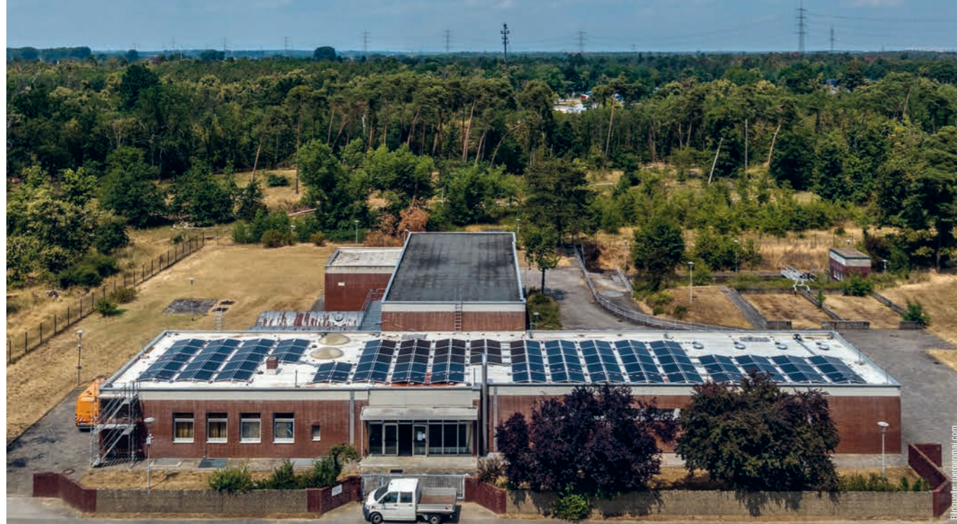
Durch den stetigen Ausbau der Strom-Eigenerzeugung verkleinert Hessenwasser den CO 2 -Fußabdruck bei der Wassergewinnung und -aufbereitung.
